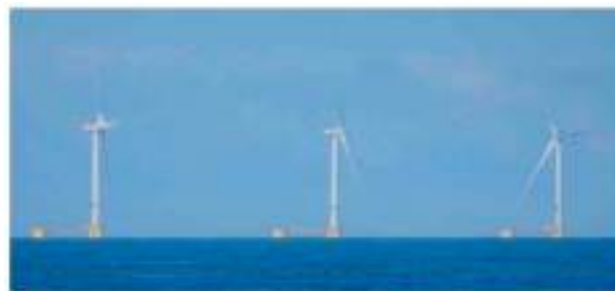
Figura 6C-8. WindFloat Atlantic ao largo de Viana do Castelo. Adaptado de Fonte: WindFloat Atlantic , acessado a 05.07.2024, em: https://www.windfloat-atlantic.com/
