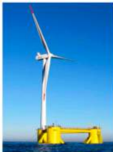
Figura 6C-5. Tecnologia flutuante instalada no parque eólico offshore WindFloat Atlantic : Adaptado de WindFloat Atlantic .
