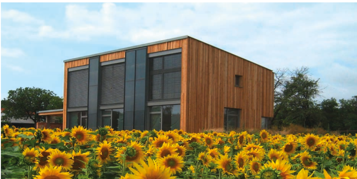
Solar house Oberduernbach, Austria
